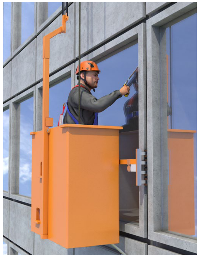
Abb. 62 Fassadenreinigung mit Fassadenbefahranlage
