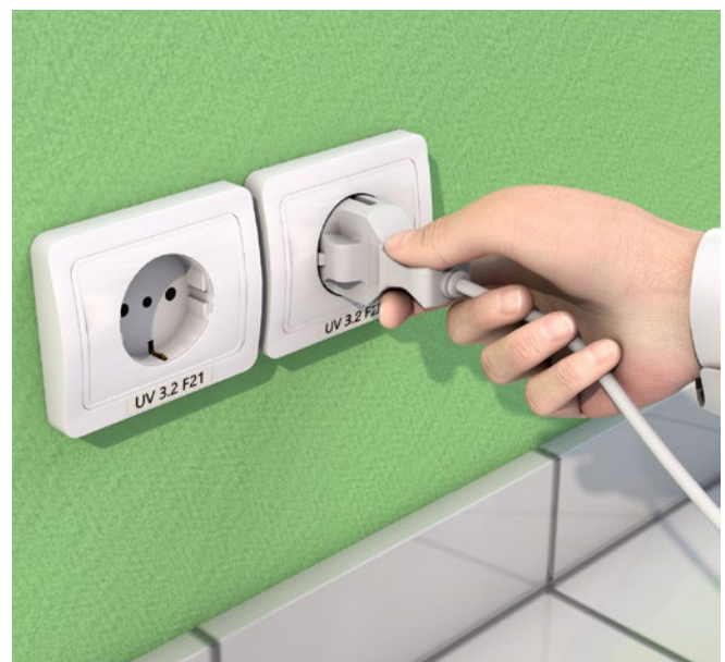
Abb. 17 Richtiges Ziehen des Steckers
