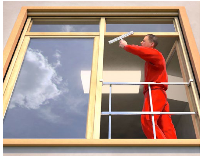
Abb. 3 Mobiles Schutzgeländer in Fensterrahmen
