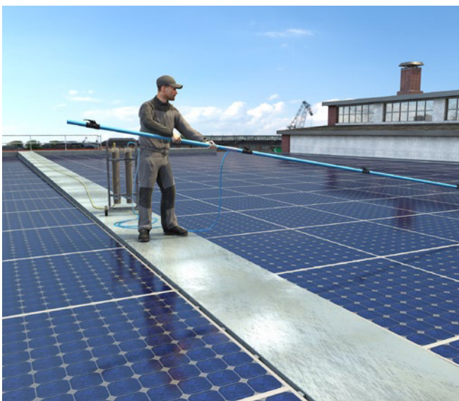
Abb. 16 Reinigung von Photovoltaikanlagen mit entmineralisiertem Wasser
