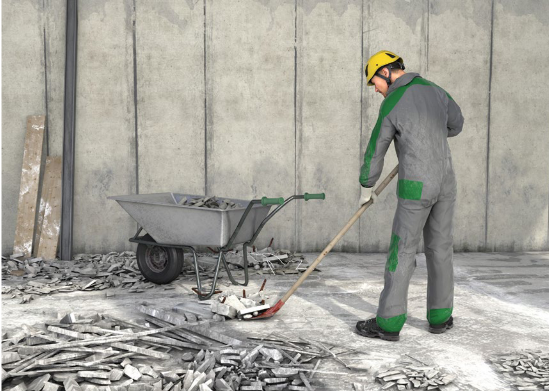
Abb. 69 Grobschmutz mit Schaufel aufnehmen
