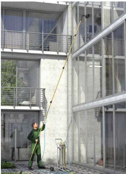
Abb. 63 Reinigen mit entmineralisiertem Wasser
