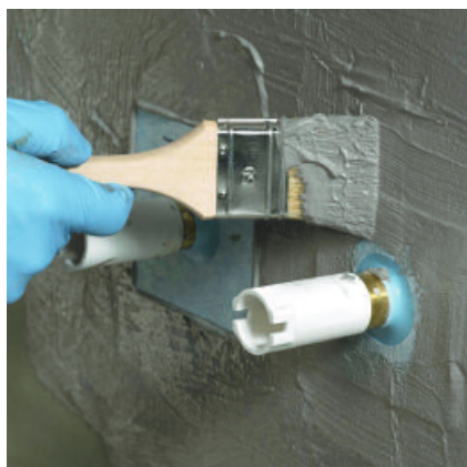
Die Dichtmanschetten PCI Pecitape 10 x 10 ordnungsgemäß einbetten.
