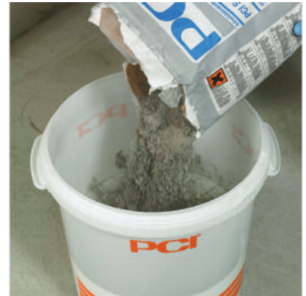
PCI Seccoral 2K Rapid Pulver dazugeben.
