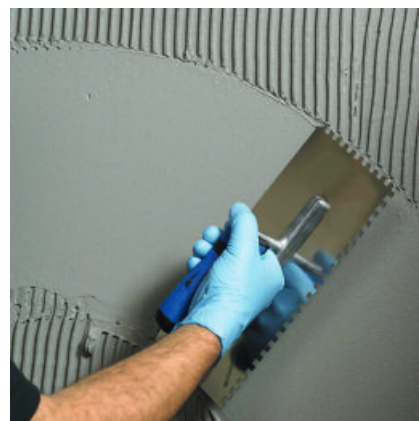
2. und evtl. 3. Auftrag im Spachtelverfahren mit einer geeigneten Glättkelle bis zur geforderten Gesamtschichtstärke aufbringen.
